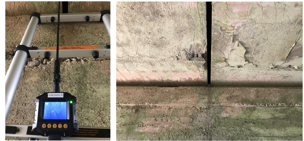
FIGURE 78 – INSPECTION DES FISSURES ET JOINTS DE DILATATION DES PONTS SNCF DE LA ZONE D'ETUDE (SOURCE : ING ENVIRONNEMENT)
